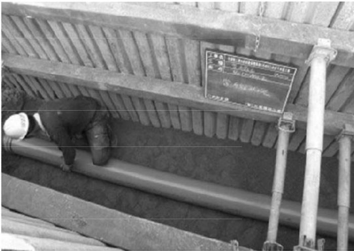
下水道管布設工事（管布設）
