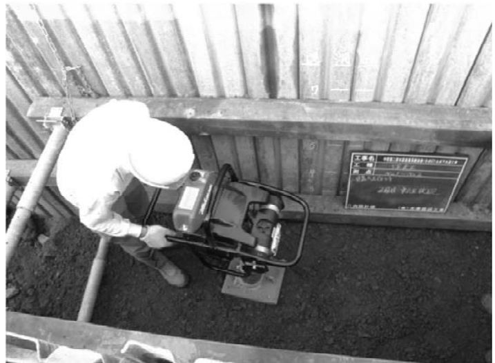
下水道管布設工事（埋戻し）
