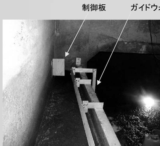
雨水吐室水面制御装置状況
