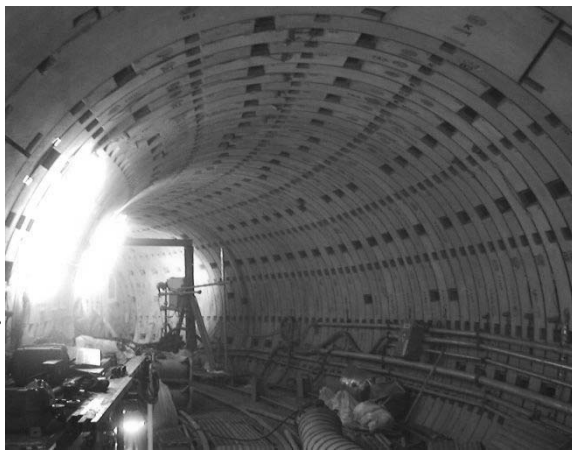
雨水貯留幹線の整備工事
