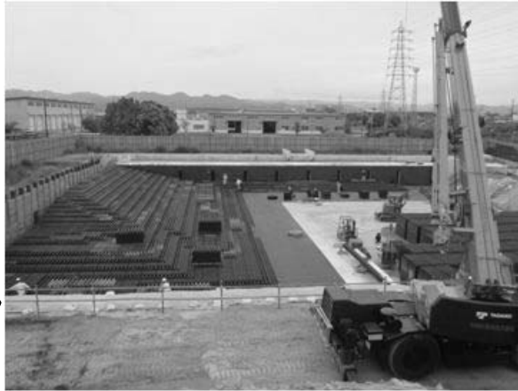
雨水調整池の整備工事
