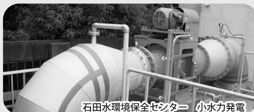
石田水環境保全センター 小水力発電
