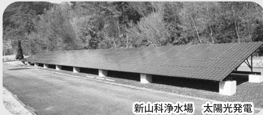
新山科浄水場 太陽光発電
